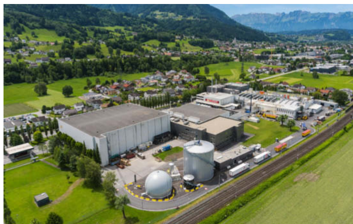
Unübersehbar steht die Methangas-Anlage auf dem 11er-Werksgelände in Frastanz.
