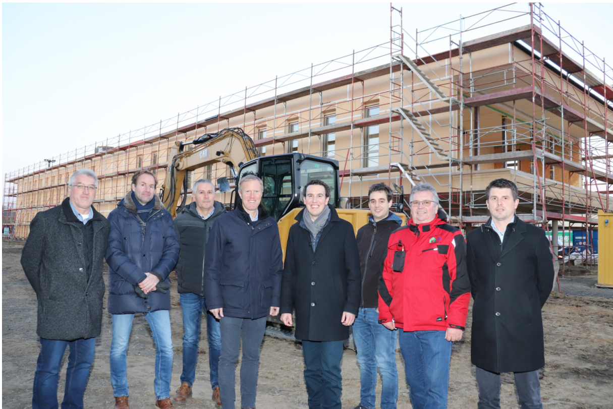
© Foto: NÖN/Rupert Kornell; am Foto von links: Ing. Erich Rohrmüller (Bauleitung, Graf-Holztechnik GmbH), BM Ing. Klaus Beron (örtliche Bauaufsicht, YES WE PLAN!), Johannes Pfeffer (Tischlermeister, Geschäftsführung PSP Holz GmbH), Mag. Julius Kiennast, Mag.(FH) Alexander Kiennast, DI Johannes Harrauer (statische Bearbeitung, Zehetgruber + Laister ZT GmbH), Andreas Halmetschlager (Schwarzdecker/ Spengler, Geschäftsführer HALMETSCHLAGER GmbH), Ing. Christian Wildeis (Gruppen/ Standortleiter, Swietelsky AG)
